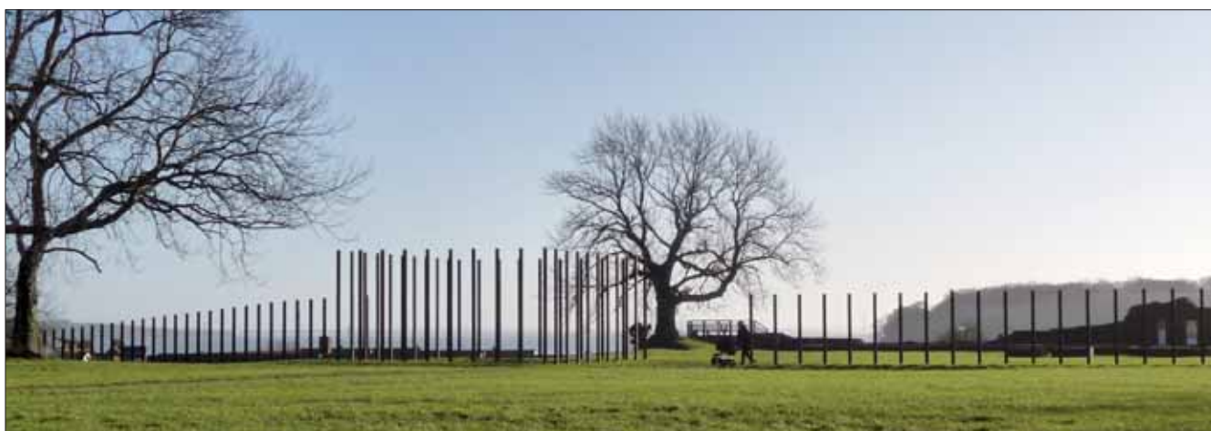
Fig. 4. Centralborgens ringmur er markeret med høje stænger af cortenstål.
