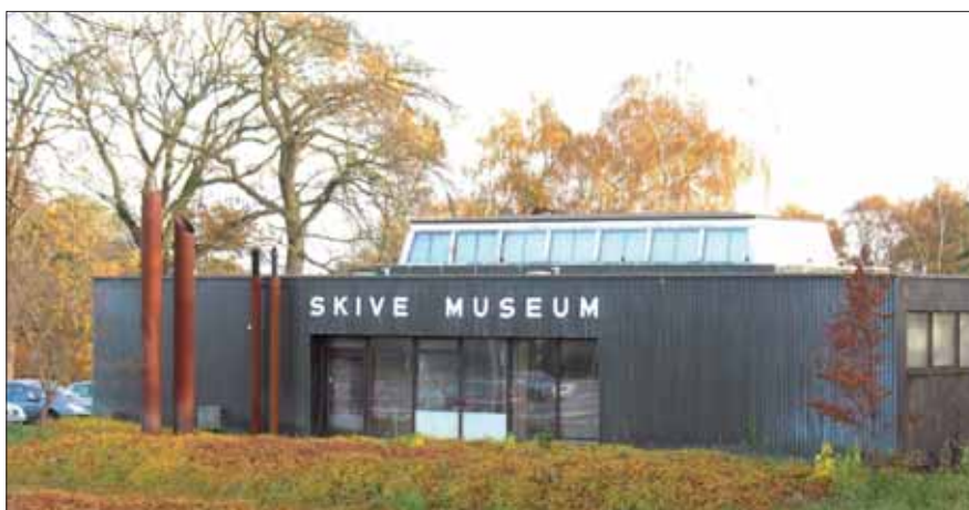
Fig. 2: Den ny museumsbygning, indviet i 1942
